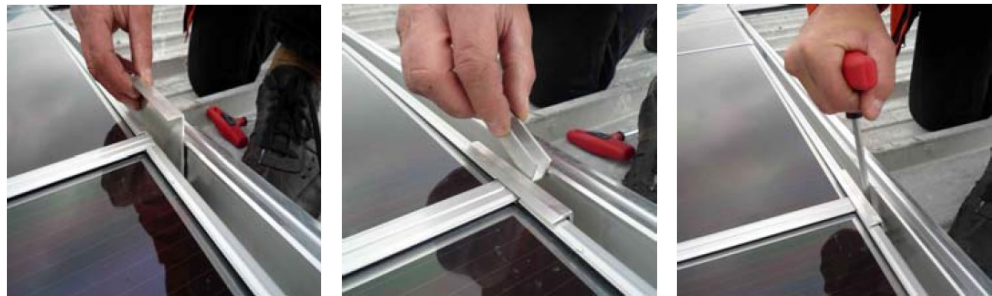
Abbildung 5: Einlegung der Module des ClickRail Systems von ClickCon per „C-Halter“ sowie Nut und Feder (ClickCon 2011)
