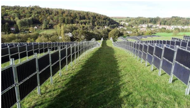
Fig. 20 Beschattung der Reihenzwischenräume am Nachmittag auf der Agri-PV-Anlage von Next2Sun in Dirmingen (Blick von Süden nach Norden) (Foto: Next2Sun).
