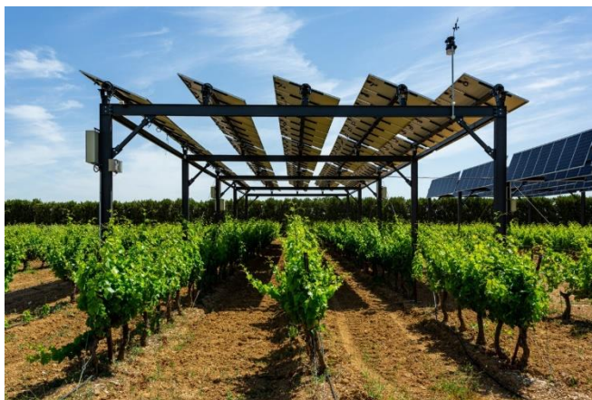
Fig. 29 Sun' Agri Agri-PV-System über Weinreben im Drahtrahmenanbausystem (Rollet, 2021).
