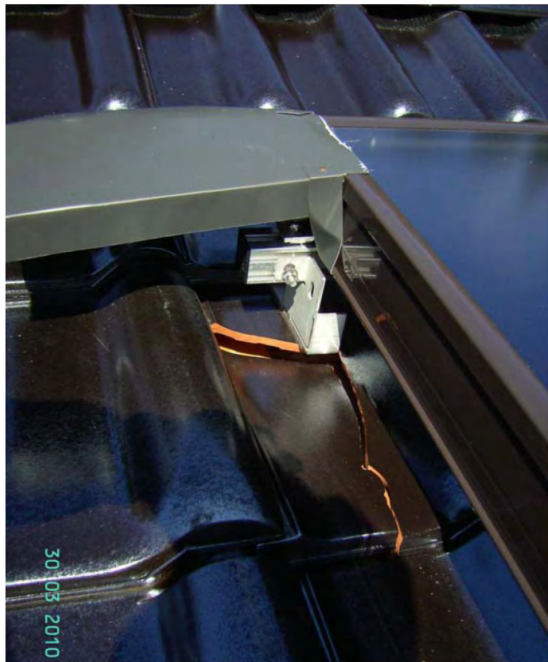
Abbildung 17: Ziegelbruch (Quelle: Kunde Solarthermie Anbieter)
