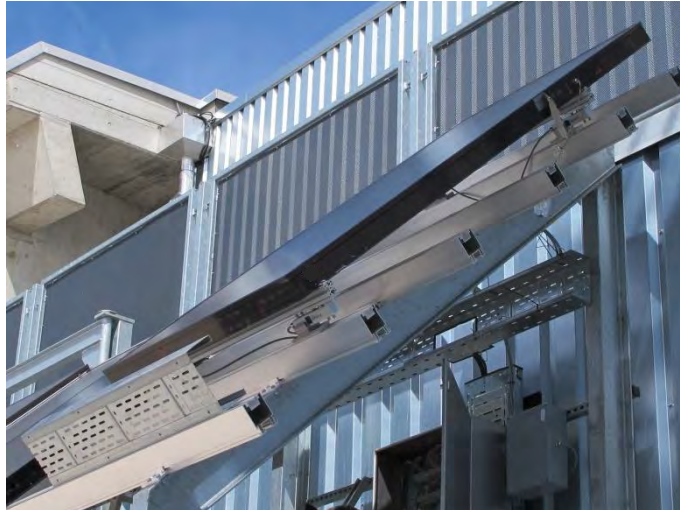
Abbildung 40: Kollektor mit Schneefangschiene (wurde wieder deinstalliert, Quelle: Fraunhofer ISE)
