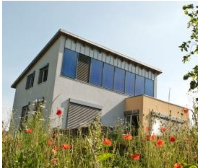
Abbildung 38: Testgebäude mit in der Fassade montierten Kollektoren
