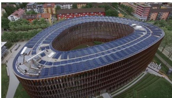
Das neue Rathaus im Stühlinger in Freiburg: als Nullenergiegebäude geplant und umgesetzt. Messungen aus den Jahren 2018 und 2019 zeigen: das Konzept funktioniert. © Fraunhofer ISE
