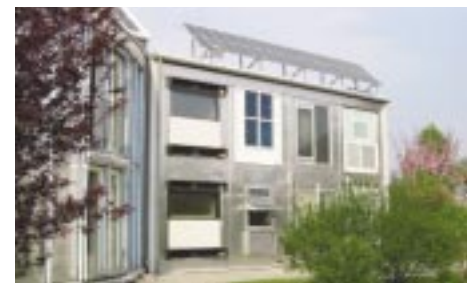
Abb. 1: Fassadenteststand des Fraunhofer ISE: In der Mitte übereinander die beiden Leichtbauzellen.
