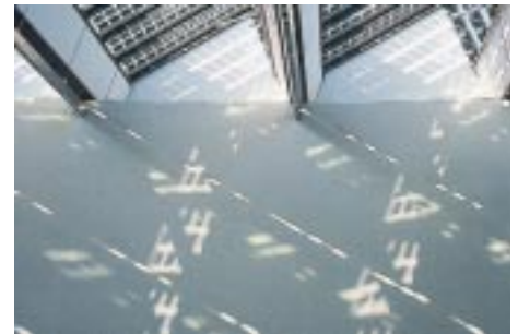
Abb. 4: Shed-Dach mit integrierter Photovoltaik im Atrium des Fraunhofer ISE Neubaus.
