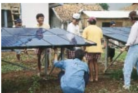
Abb. 1: Installation einer PV-Hybridanlage in Indonesien.
