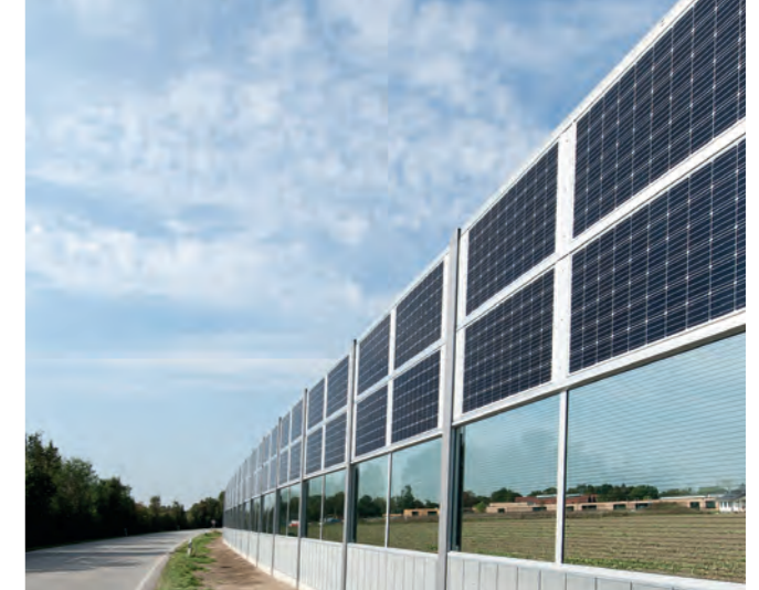
Lärmschutzwand mit integrierten Modulen. © KOHLHAUER GmbH
