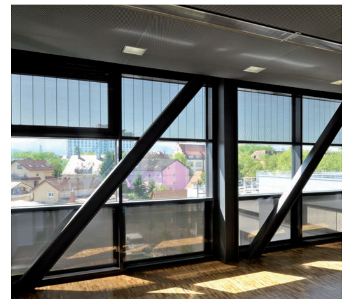
Sonnenschutz mit optimiertem Durchblick nach außen.
