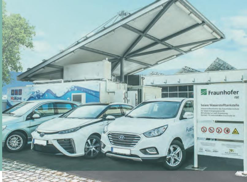
2 Wasserstoff-Tankstelle mit Brennstoffzellen-Fahrzeugen.
