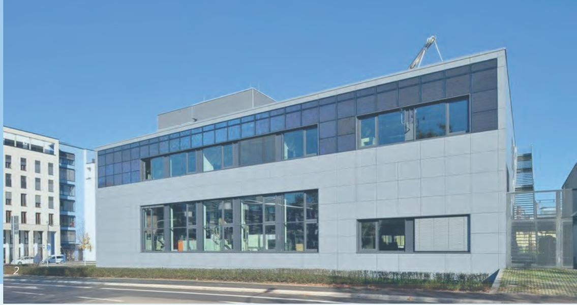
2 70 Photovoltaik-Module aus eigener Entwicklung und Pilotproduktion des Fraunhofer ISE an einem Laborgebäude des Instituts
